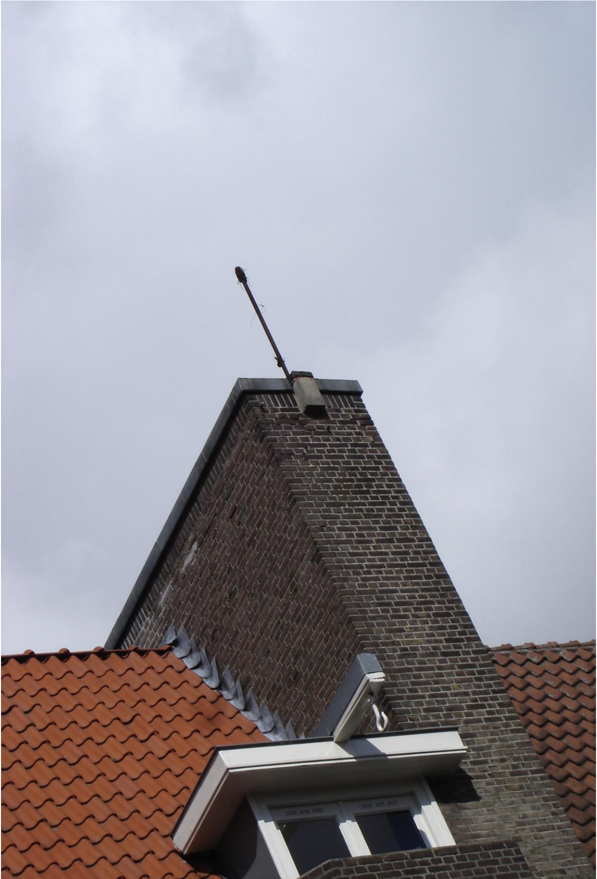
Details die de leerlingen opvielen: dakraampje, takelhaak, schoorsteen, mast ...
